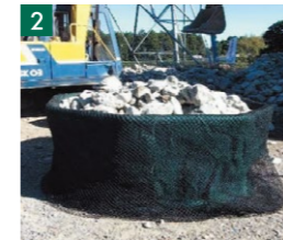
2 スーパーE-ユニットに中詰め材の充填します。
