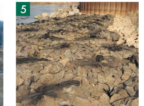
5 スーパーE-ユニットを布設します。
