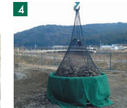
4 製作型枠からスーパーE-ユニットをクレーン等で吊り上げます。
