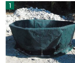
1 製作型枠にスーパーE-ユニットを設置します。
