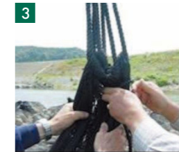
3 スーパーE-ユニットの口縛りを行います。
