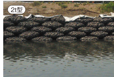
2t型 平成24年度 1号同心橋 橋脚補強工事
