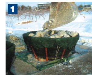
1 製作型枠内にE-UNITを設置し、中詰め材を投入します。
