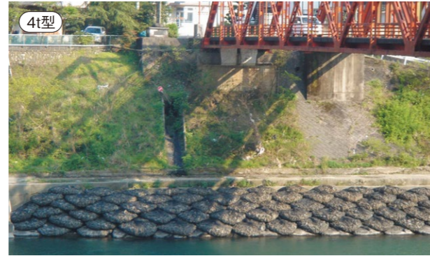
4t型 坂本地区災害復旧工事
