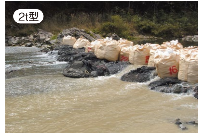
2t型 小丸川上名木地区河川改修工事
