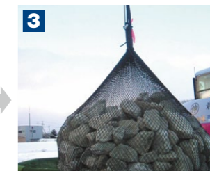
3 型枠からE-UNITをクレーン等で吊り上げます。
