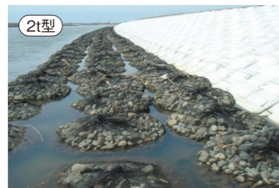
2t型 横田中流部低水護岸工事
