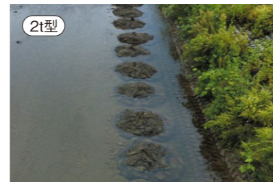
2t型 平成25年度 一級河川維持修繕工事
