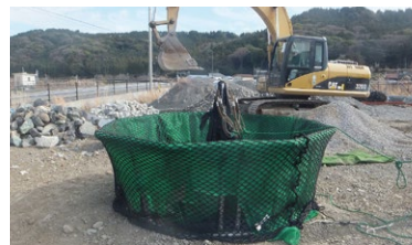
① 網材を専用型枠へ装着
