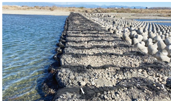
●埼玉県 護床工として使用
