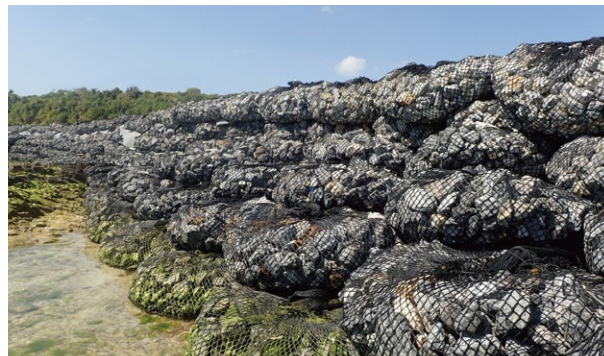
●沖縄県 仮設道路として使用
