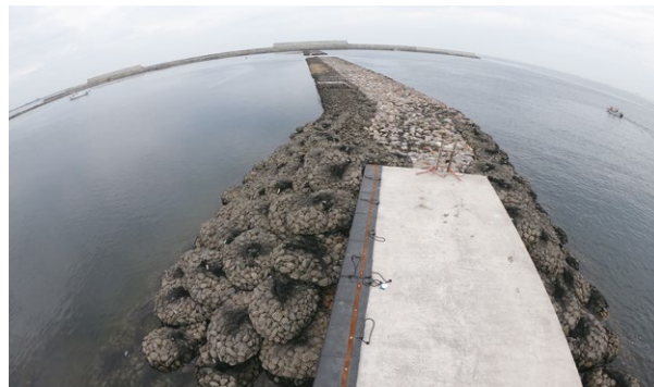
●新潟県 被覆材として使用
