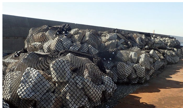
●神奈川県 護岸の裏込工として使用
