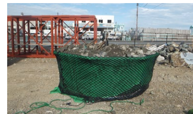
② 中詰め材を投入
