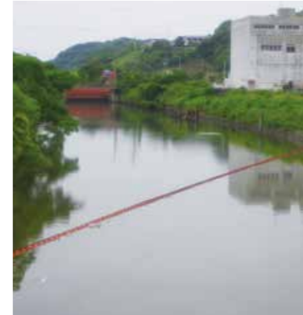
福岡県 曲川鯨瀬排水機場 集塵網
