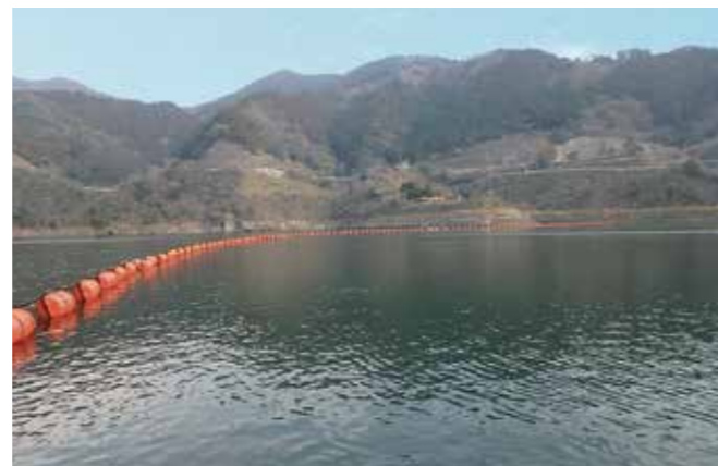
九州地方整備局 巖木ダム
