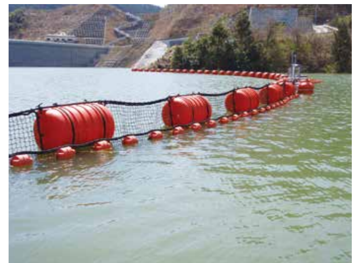
静岡県 太田川ダム(網場併設) 網場・集塵網
