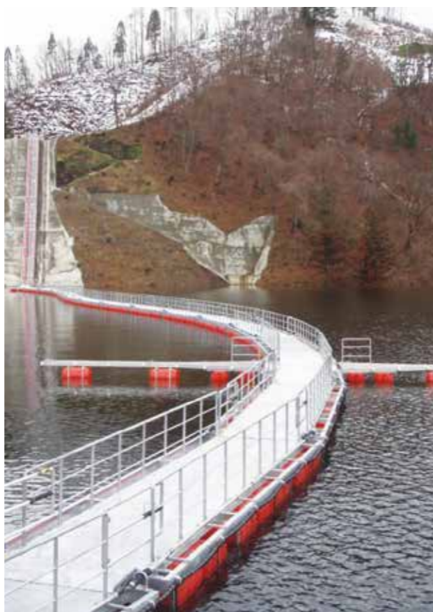
水資源機構 徳山ダム
