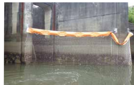
茨城県 長井戸沼排水機場 ネットフェンス
