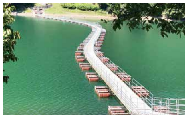
東京都 小河内ダム
