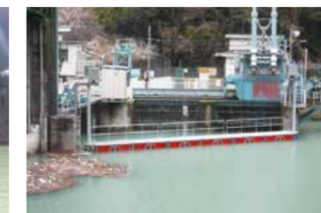
奈良県 黒瀬ダム
