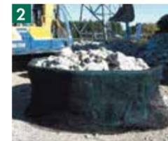
②スーパーE-ユニットに中詰め材の充填します。
