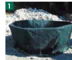
①製作型枠にスーパーE-ユニットを設置します。
