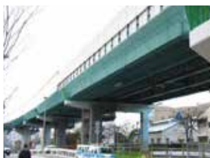
剥落防護ネット
