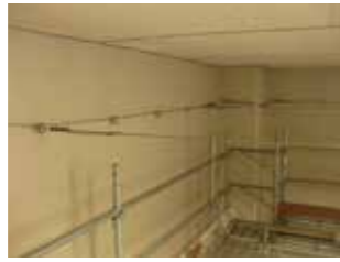
② 金具を取り付け、ワイヤーを張ります。
