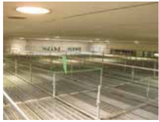
① 足場を組み立てます。
