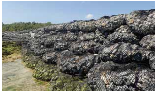
● 沖縄県 仮設道路として使用
