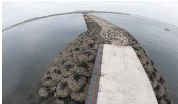
● 新潟県 被覆材として使用
