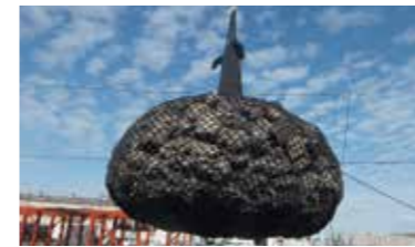
④ 吊り出し⇒仮置き
