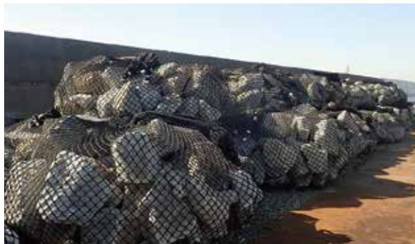
● 神奈川県 護岸の裏込工として使用
