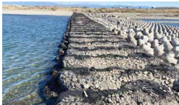
● 埼玉県 護床工として使用
