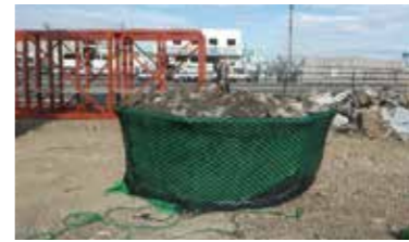
② 中詰め材を投入
