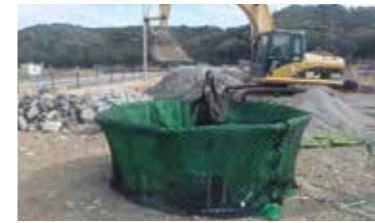
① 網材を専用型枠へ装着
