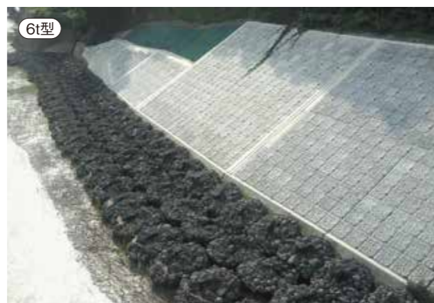
福島県 堤防の根固めとして
