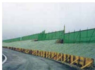
工事現場の防塵・防砂用
