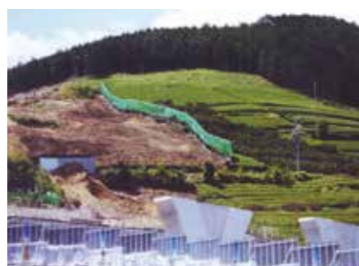
第2東名工事現場の防塵・防風用
