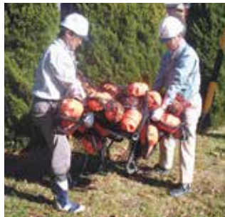
M60型L=20mで重量が45kg。人力で運搬・設置・撤収が可能です。
