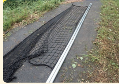
① 下部単管パイプ(錘)取付け
