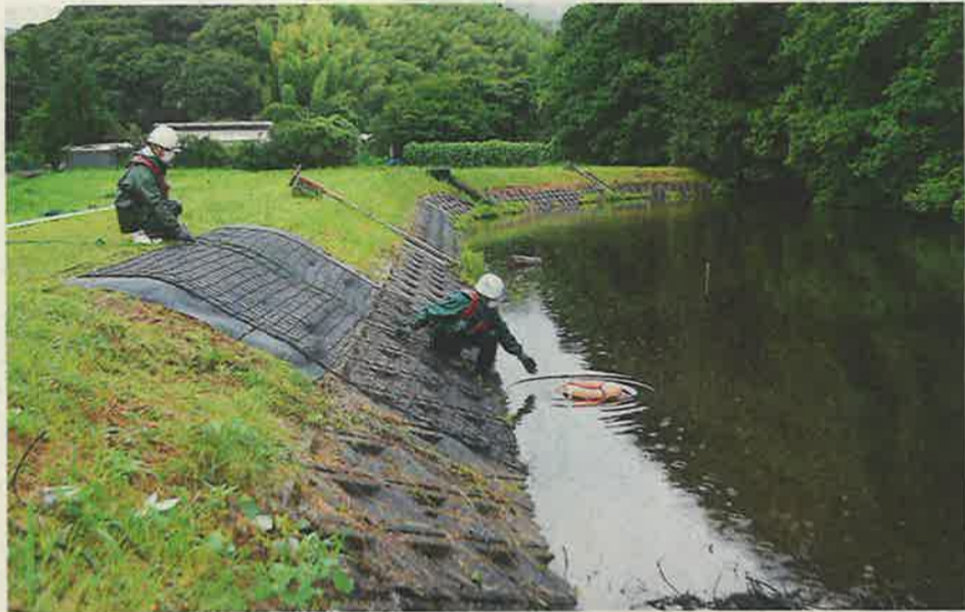
ため池ののり面に設置された安全ネット
