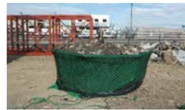
② 中詰め材を投入
