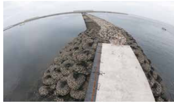
● 新潟県 被覆材として使用
