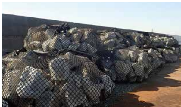
● 神奈川県 護岸の裏込工として使用
