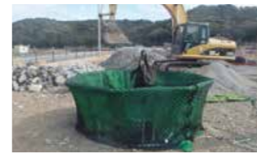
① 網材を専用型枠へ装着
