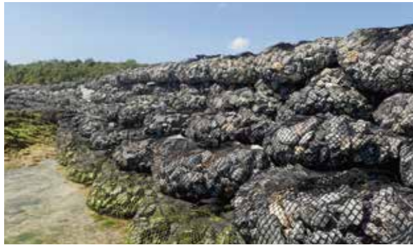
● 沖縄県 仮設道路として使用
