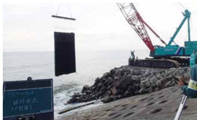
●宮崎県 突堤の沈下防止工として
