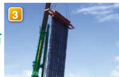
3 吊り上げます。
