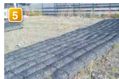
5 吊り出して完成。
