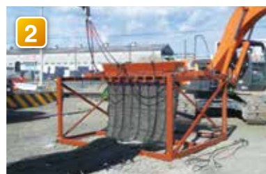
2 中詰め材を投入します。
