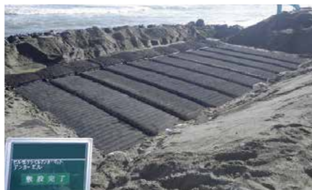
●宮崎県 埋設護岸の基盤沈下対策工として
