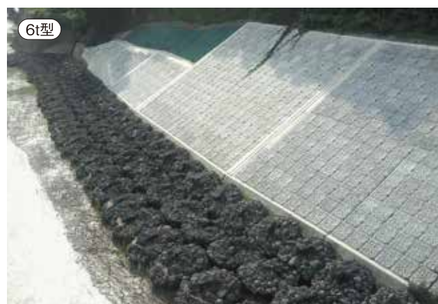
6t型 福島県 堤防の根固めとして
