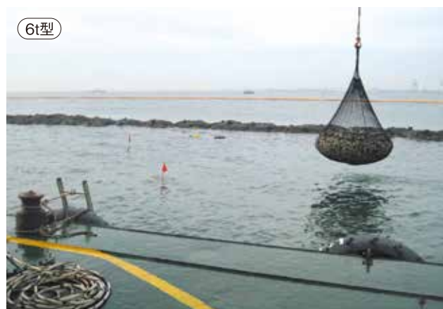
6t型 兵庫県 洗掘防止材として
