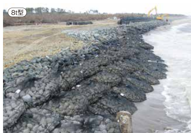
8t型 宮城県 海岸の洗掘防止材として
