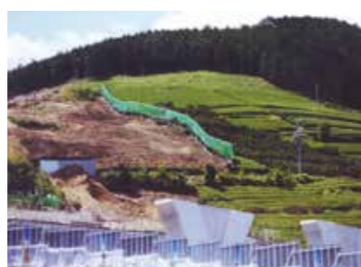
第2東名工事現場の防塵・防風用
