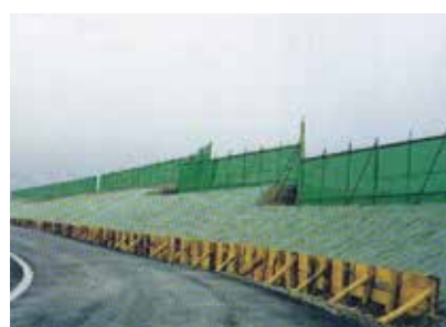
工事現場の防塵・防砂用
